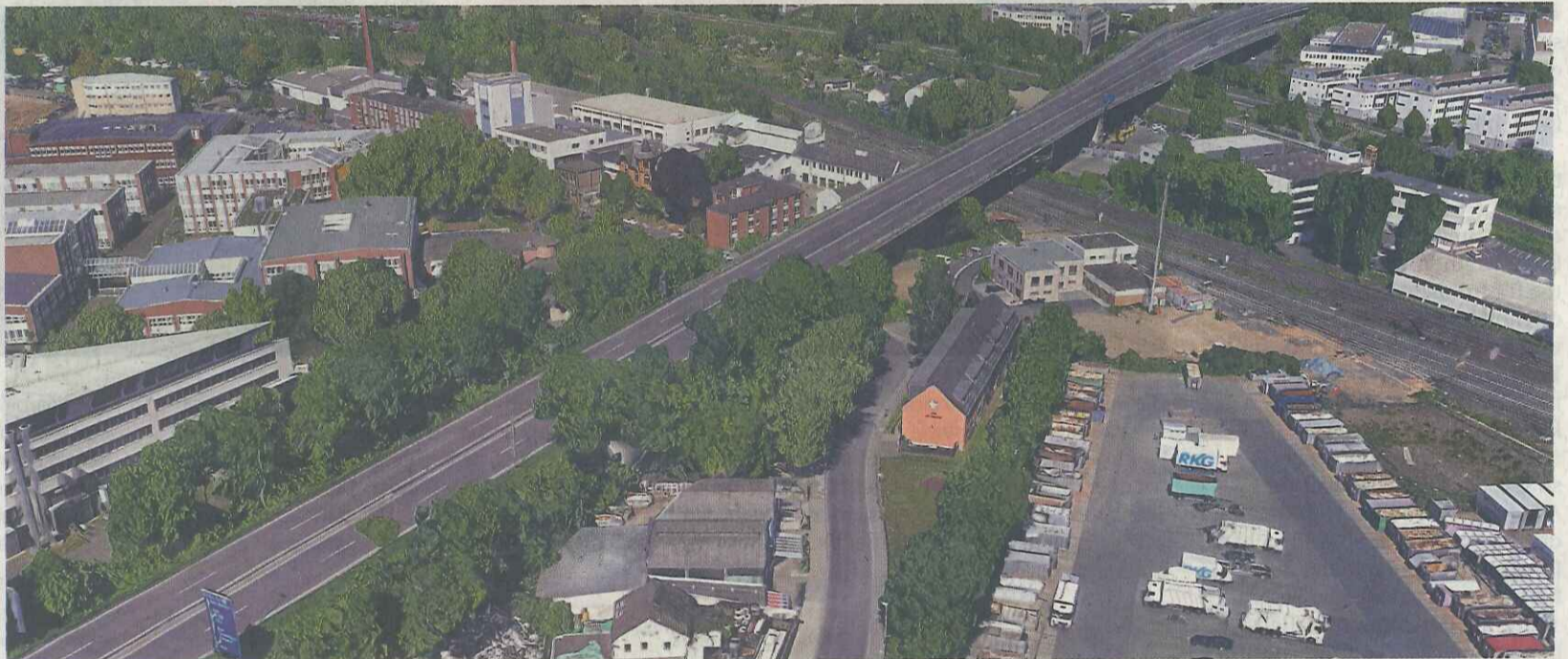
Die Animation oben zeigt, wie der Tausendfüßler nach dem Neubau aussehen soll, die Ansicht unten den Ist-Zustand.
